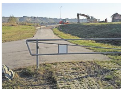
Kein Durchkommen: An der Panzerstraße wird die Zufahrt gebaut. F.: Keller
